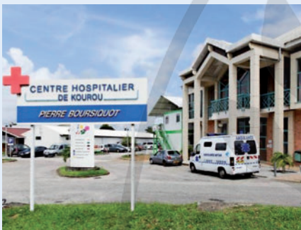
► Abb. 2 Centre Hôpital in Kourou. Quelle: Dr. Frederik Frenzen
